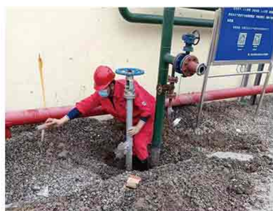
针对冬季易冻易凝问题，品管调运中心制定严密计划，加大巡检力度，在巡检中第一时间发现罐区设备管线内存水问题，并及时整改，确保防冻防凝工作不放过任何问题。 刘爱光 / 品管调运中心
